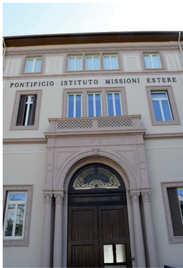
A sinistra: la facciata della casa madre del Pontificio Istituto missioni estere, in via Monte Rosa 81. Sotto: padre Mario Ghezzi nel cantiere del nuovo Centro Pime di Milano. Quello che sta sorgendo è un vero e proprio polo culturale e missionario che intende rivolgersi a milanesi di ogni età e condizione, a partire dai giovani
